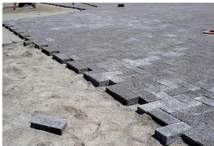
Figura 11 – Aplicação de um pavimento com bloco de concreto permeável
